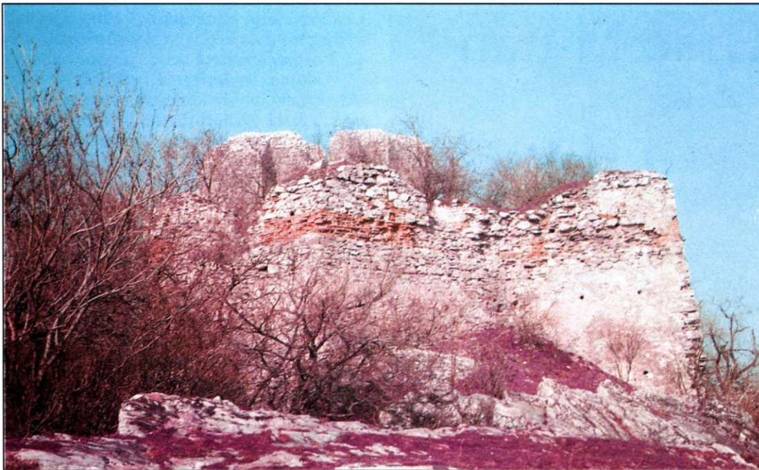
Bastiónové opevnenie južného predhradia Foto M. Bóna
