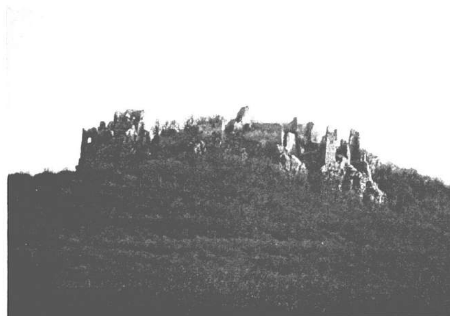
1. Celkový pohľad na hrad od severozápadu. Foto M. Bóna 1995.
